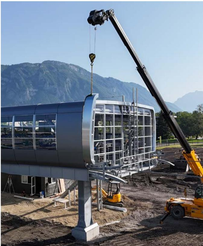
Diese Anlage, zertifiziert für den Personentransport, stellt einen bedeutenden Fortschritt in der Industrialisierung kuppelbarer Systeme dar. Sie ermöglicht es Betreibern und Partnern der Gruppe, die ORIZON™-Technologie unter realen Einsatzbedingungen zu testen – insbesondere den Direct-Drive, das schwerkraftbasierte Fördersystem sowie das modulare Design, das speziell für einen
